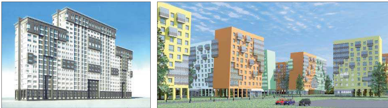
Рис. 7. Новое поколение крупнопанельных и каркасных зданий Fig 7. A new generation of large-panel and frame buildings
