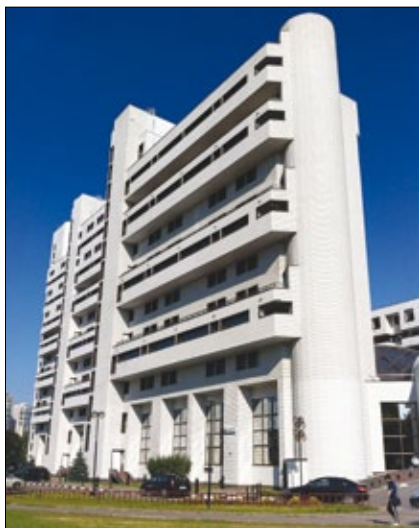
Рис. 5. Офисно-жилой комплекс «Парк-Плейс»
